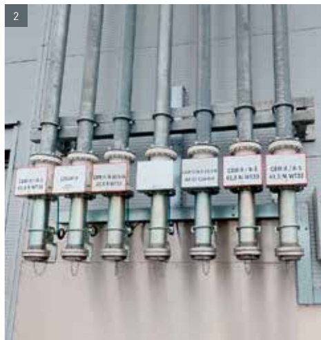
1. Bindemittelsilos auf Betriebsgebäude / Cement silos on company building ■ 2. Zentrale Einblasstation für Zement / Central filling point for cement ■ 3. Steuerraum / Control room
