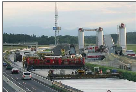
Abb. 1 Autobahnbaustelle mit EUROMIX Anlage
