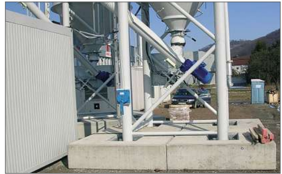
Abb. 1 Mobile Silofundamente
