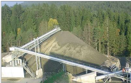
Abb. 1 Durchdachter Materialfluss ist alles – ob in einer Aufbereitungsanlage oder beim Material-Handling
