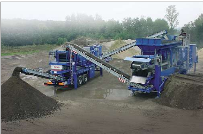
Abb. 3 Eine komplette Anlage: Radmobile Aufbereitung mit Brechanlage RCL 1338 E/D und Siebanlage 14/50-1
