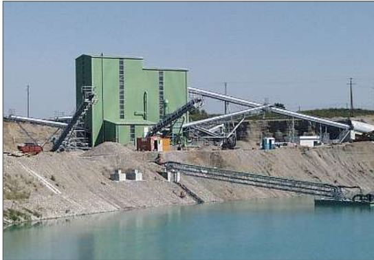
Abb. 1 Kieswerk für 500 t/h Gewinnungs- und 300 t/h Produktleistung
