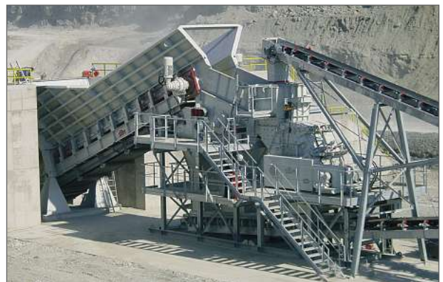
Abb. 3 Aufbereitungsanlage für Gipsstein
