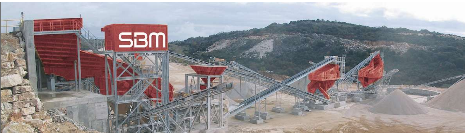
Abb. 1 Gesamtanlage mit zwei Prallbrecherstufen und Finalsiebung, Anlagenleistung 500 t/h
