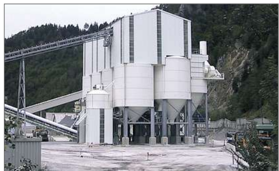
Abb. 3 Kalksteinaufbereitung mit Backenbrecher und 3 Prallbrechern, Siebanlage mit Silodeponierung
