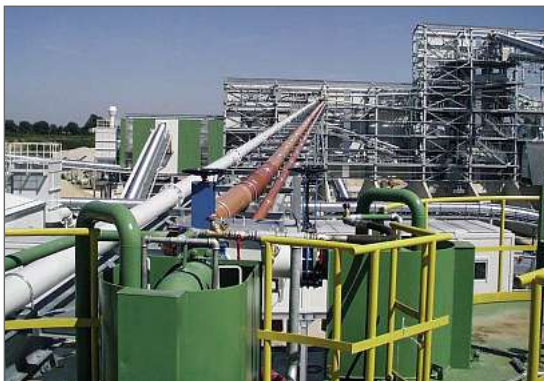
Abb. 2 Kiesaufbereitung mit Schwertwäschen und Vertikal-Prallbrecher zur Mürbkornauflösung, 5 Produktsieben, 7 Entwässerungssieben und Sand-Klassiertank, Anlagenleistung 200 t/h
