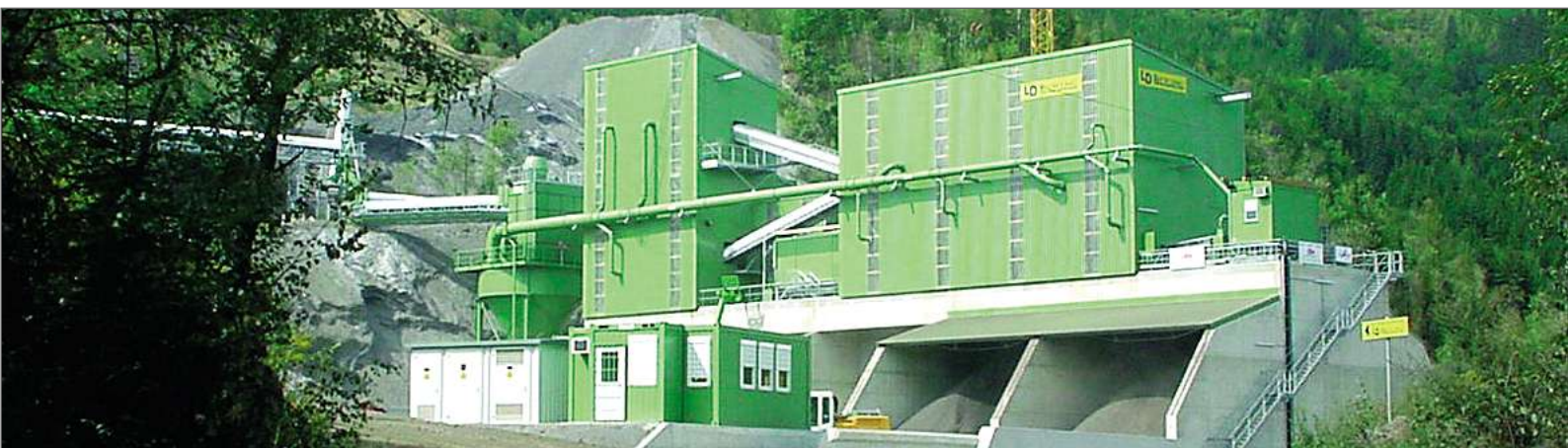
Abb. 1 LD-Schlackenaufbereitung mit Backenbrecher, Kegelbrecher und Vertikal-Prallbrecher V10
