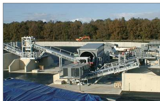
Abb. 3 Aufbereitungsanlage für Müllverbrennungsschlacke
